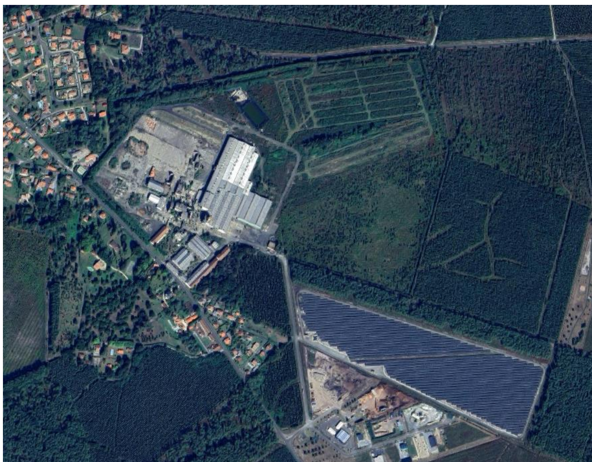
Vue aérienne de la zone projet et de la centrale photovoltaïque de VALECO © Google
