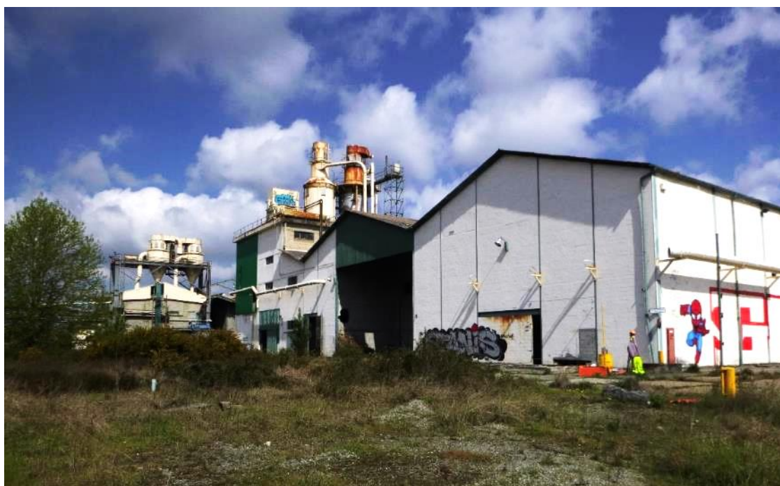
Vue sur le site © ETEN Environnement
